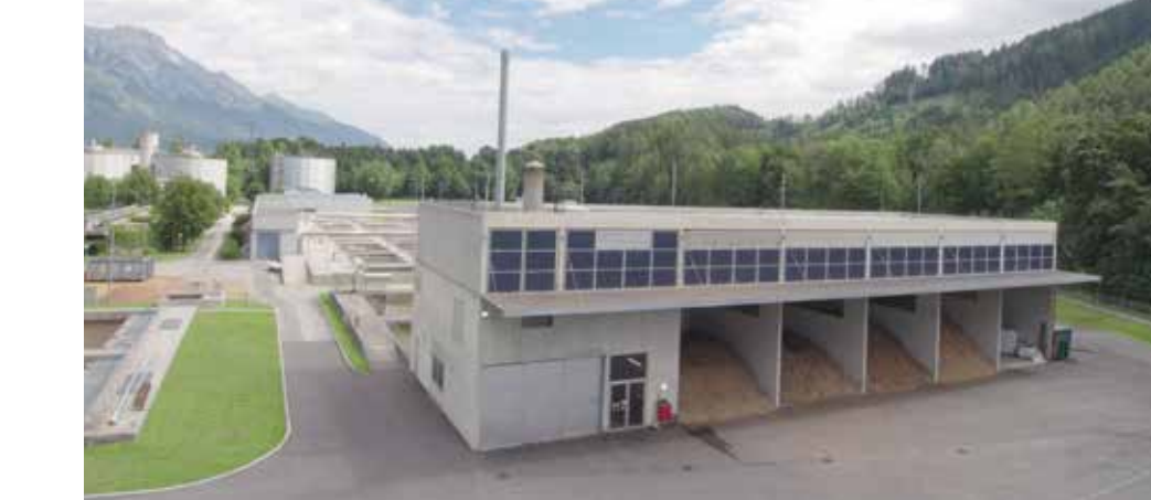
Die Syncraft-Anlage in Schwaz in Tirol.
