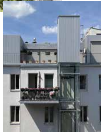
Sanierte Hausfassade mit Dachgeschossausbau in 1060 Wien
